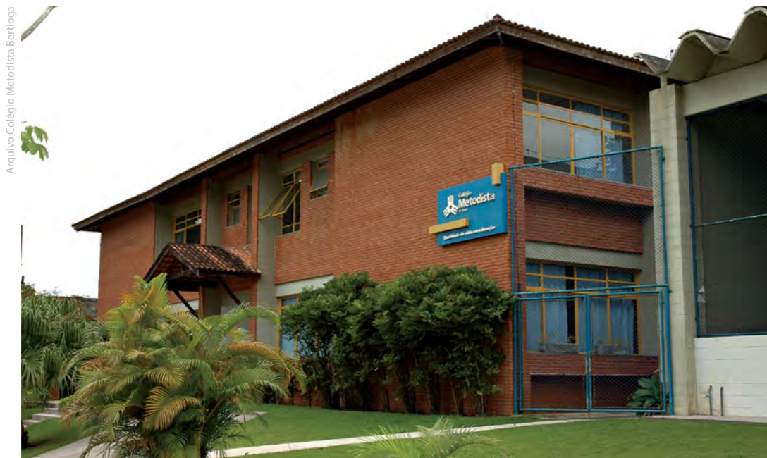
Colégio Metodista Bertioga, no Estado de São Paulo
